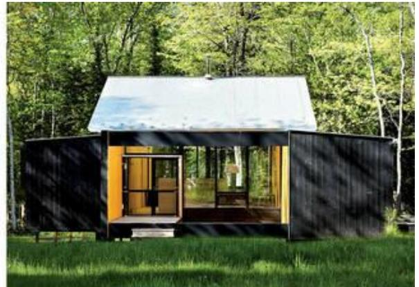
Los módulos laterales prefabricados se transportan enteros por carretera.
